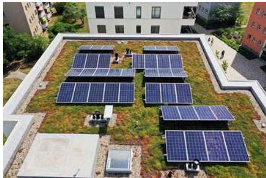
Begrüntes Flachdach mit Photovoltaikanlage
